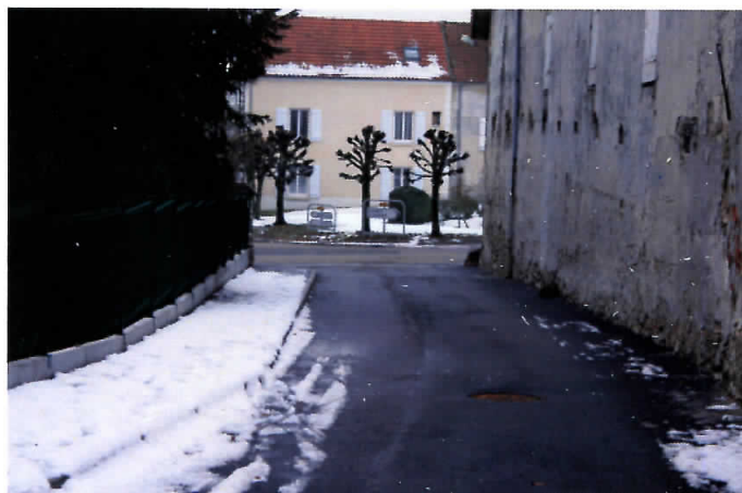
Elargissement de la rue des Postes Prolongée
